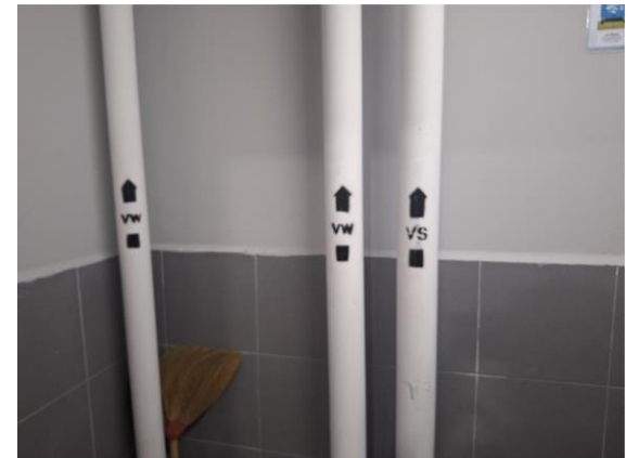
รูปที่ 2-39 ระบบระบายอากาศภายในห้องพักมูลฝอย
